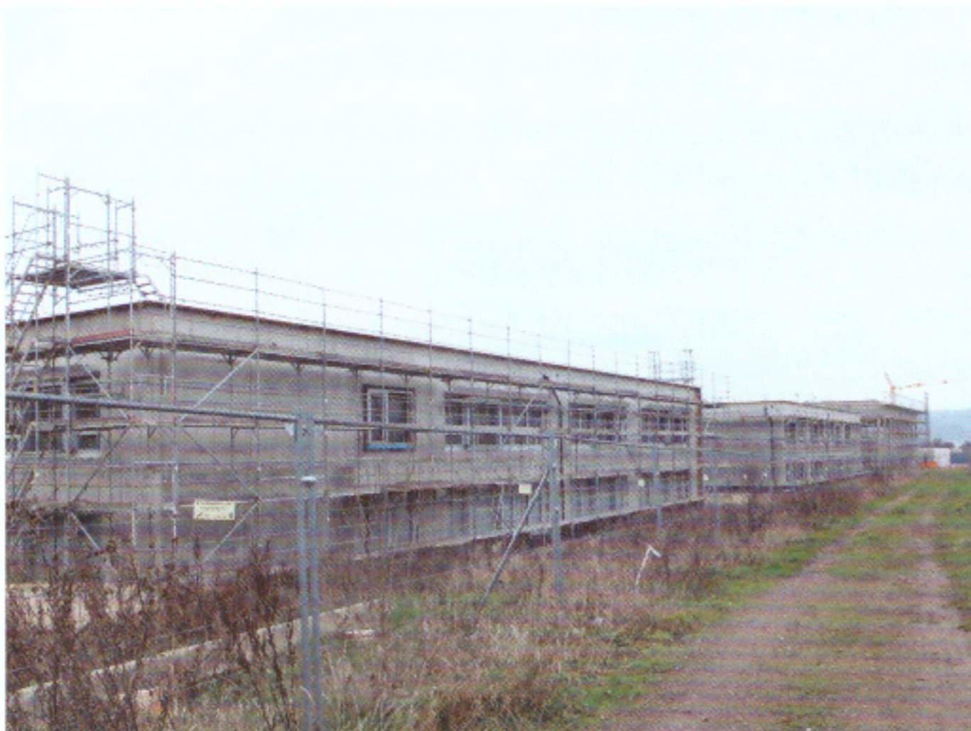
Im Bau: Das neue Schulzentrum
